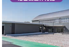
落合公園体育館
